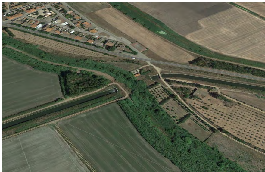
Figura 38 Sifone del Canale Adduttore sul Rio Sant'Elena
