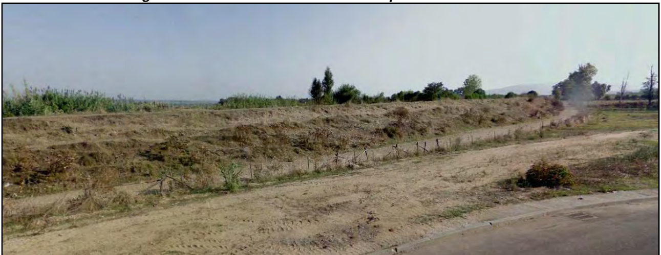
Figura 19 Argine sinistro Rio Sant'Elena
