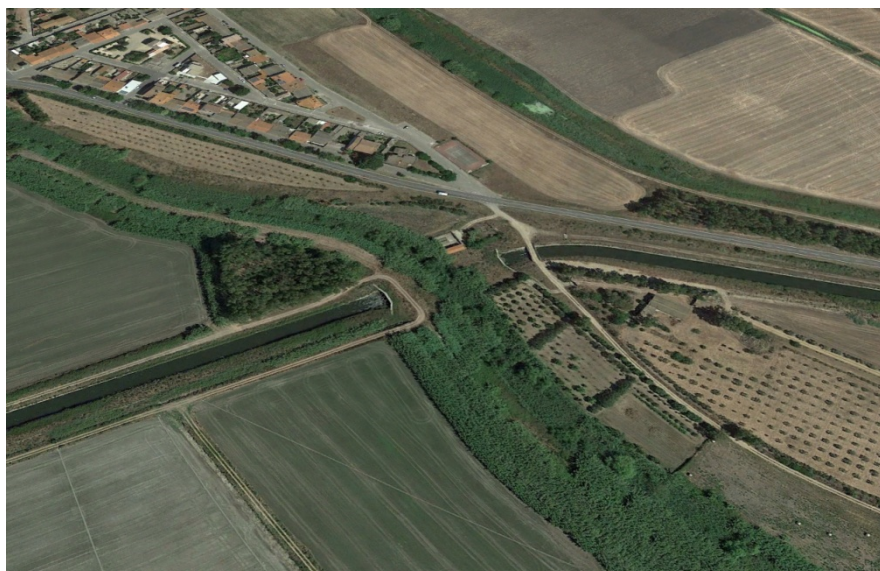
Figura 38 Sifone del Canale Adduttore sul Rio Sant'Elena
