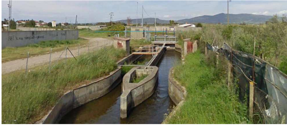
Figura 27 Diversivo canale generale 2
