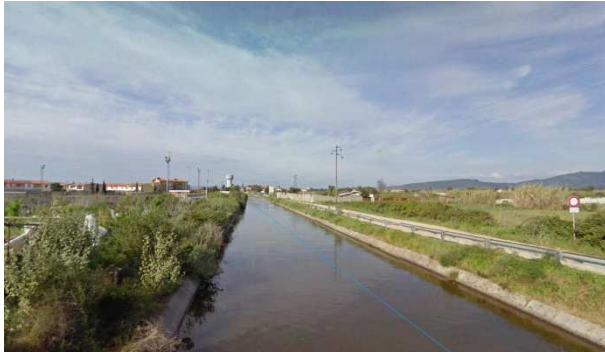
Figura 4 Canale adduttore Tirso-Arborea
